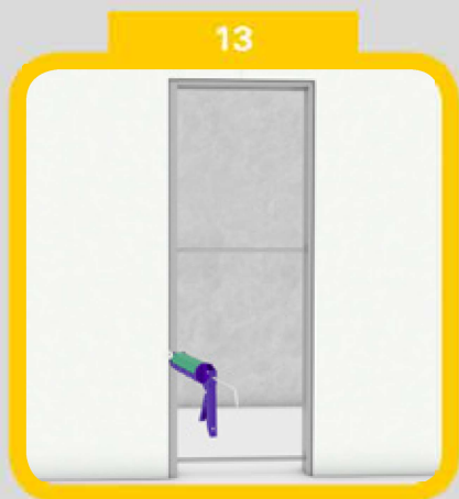
13 Zatmelení spáry mezi SDK a omítníky pouzdra vysoce pružným tmelem
