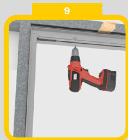
Opětovným utážením kolejnice zafixujte správnou polohu horních omítníků
